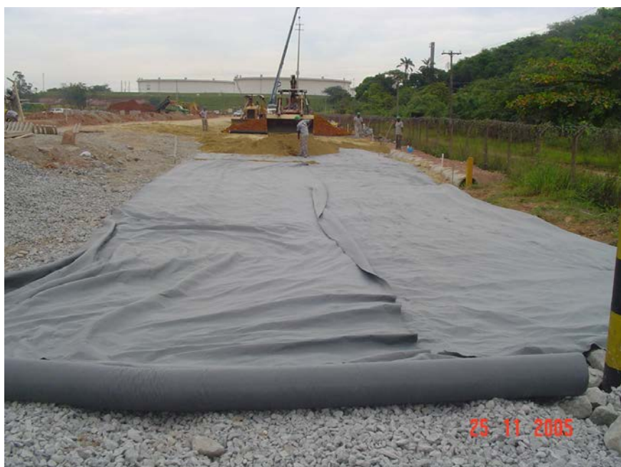
Aplicação da Manta Geotêxtil Bidim RT-16 sobre a camada de rachão.
