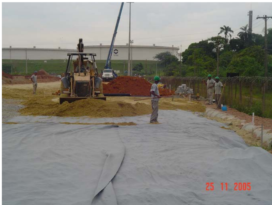
Vista geral da obra.
