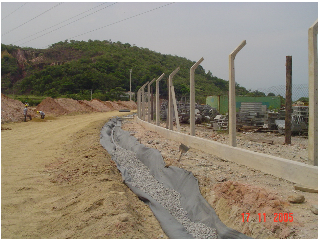
Detalhe na execução dos drenos laterais com Manta Geotêxtil Bidim RT-10.
