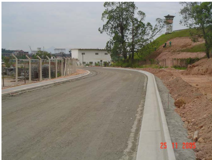
Base finalizada aguardando a execução do revestimento.
