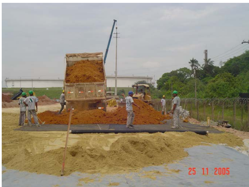
Execução da camada de areia sobre a Manta Geotêxtil Bidim RT-16.
