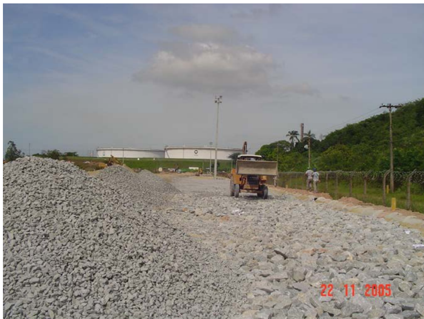
Execução da camada de rachão.
