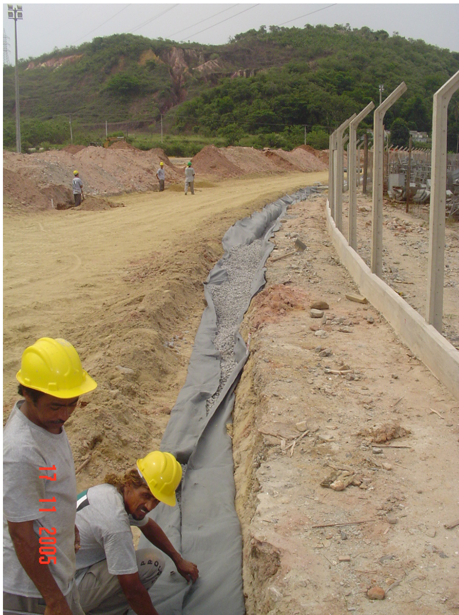
Detalhe do fechamento do dreno.
